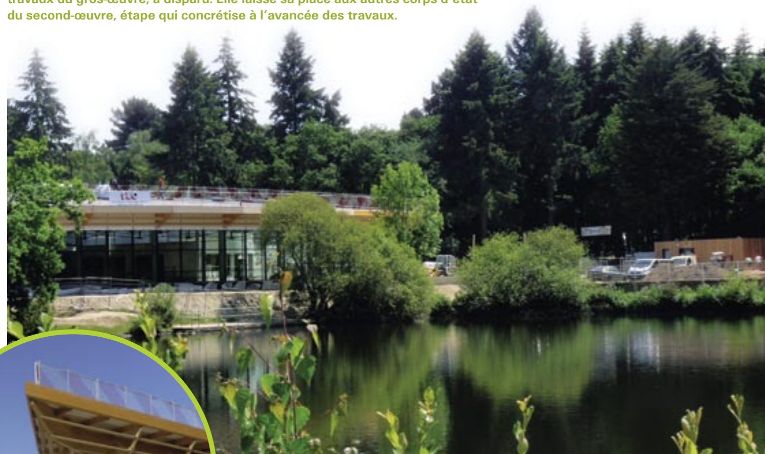
La piscine se construit au fil de l'eau.
